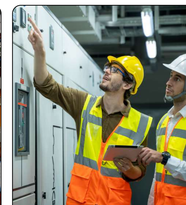
Servicios de Mantenimiento e Instalación
